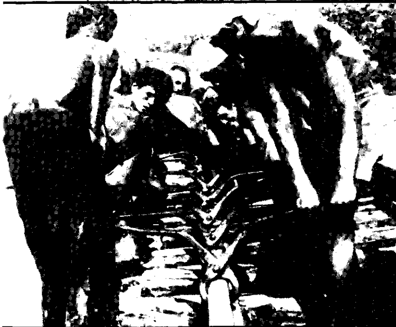
8. U PRVIM POSLERATNIM GODINAMA RUČNA KOLICA SU BILA GLAVNA MEHANIZACIJA 9. POSTAVLJANJE ŠINA NA IZGRADNJI OMLADINSKE PRUGE BRČKO-BANOVIĆI, LETO 1946.
